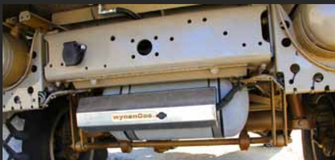
▲ Platzsparend untergebracht: Gut geschützt im und um den stabilen Leiterrahmen wurden die Zusatztanks für Wasser und Gas montiert.
